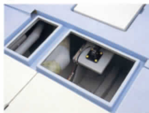
12 第4物入れハッチ
