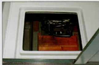
メンテナンスハッチ(ブリッジ内部)
